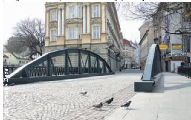
Most w ciągu ul. 11 Listopada.
