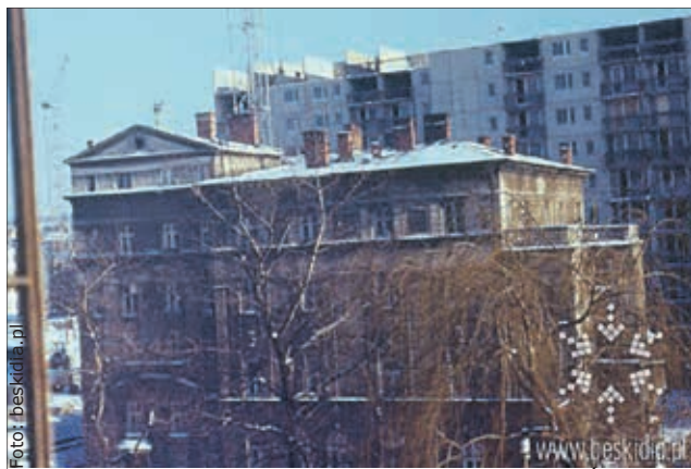
Budynek dawnego szpitala, w tle budowa osiedla Śródmiejskiego.
