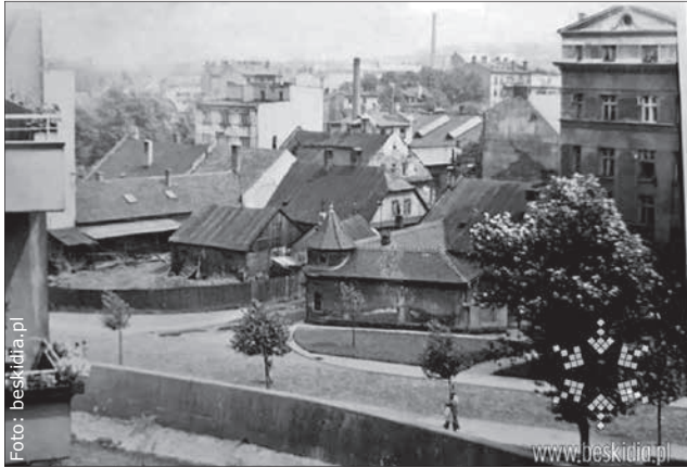
Widok na nieistniejące zabudowania Białej w okolicach dzisiejszej ulicy Dmowskiego, po prawej fragment dawnego szpitala. Zdjęcie z lat 50. XX wieku.
