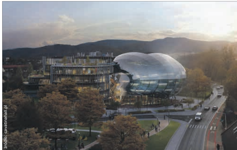
Cavatina Hall już niebawem stanie się zapewne jednym z architektonicznych symboli miasta.
