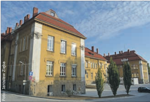
Szpital przy ul. Wyzwolenia.
