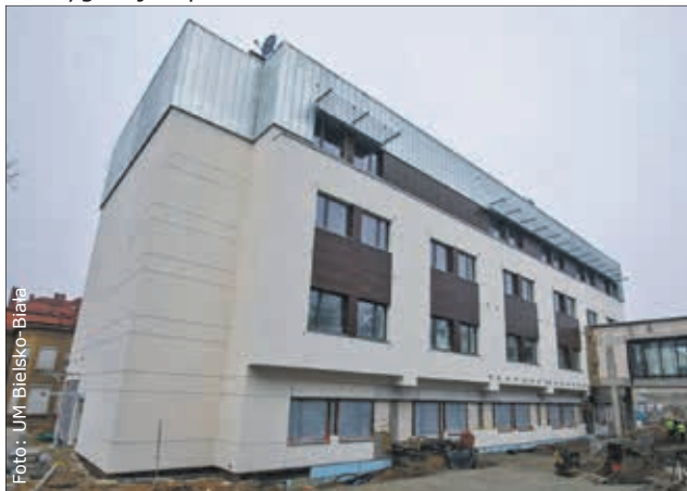
Nowy budynek Beskidzkiego Centrum Onkologii.
